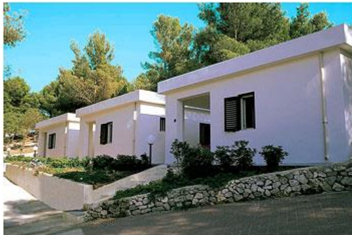
Villini trilocali muratura
