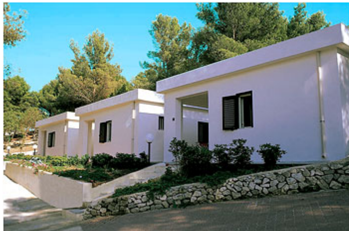
Villini trilocali muratura
