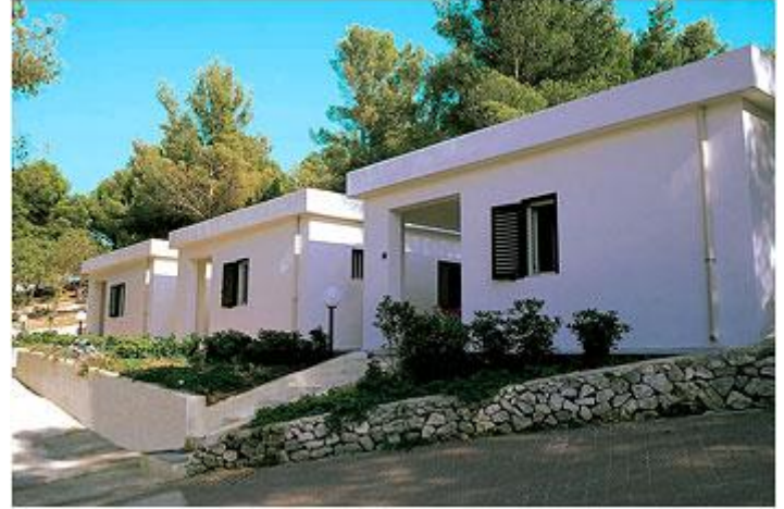
Villini trilocali in muratura
