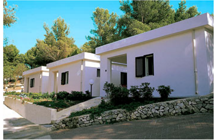
Villini trilocali in muratura
